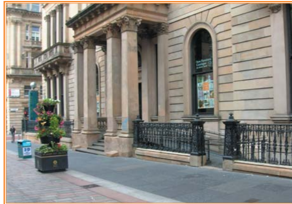
Oficina bancaria con acceso mediante rampa lateral, adaptación que mantiene el estilo y estética del edificio.
